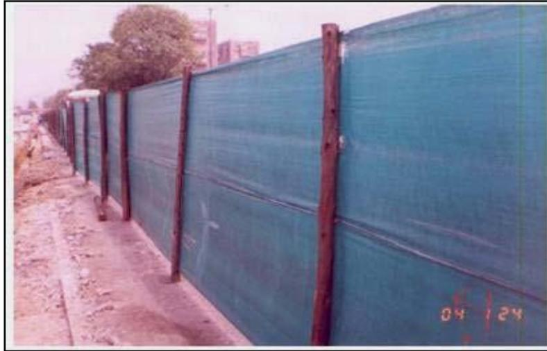
Compuesta por postes en guadua cepa de 2.60 m de longitud total, altura libre 2.10 m y enterrados 0.50 m, espaciados cada 3.0 m. La malla plástica color verde, se asegura contra los postes mediante unas varetas de madera ordinaria y con puntillas con cabeza de 1.5 pulgadas mínimo. (Adecuación de la Troncal NQS de Transmilenio en Bogotá).
