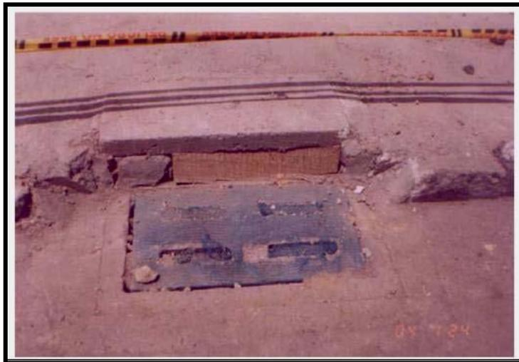
Obsérvese el estado deteriorado de la malla, debe usarse Geo textil en la tapa y en el interior. (Adecuación de la Troncal NQS de Transmilenio en Bogotá)
