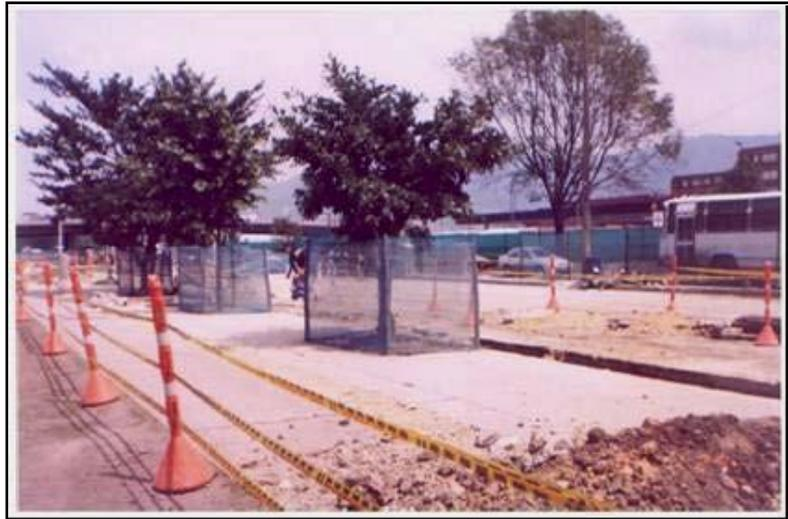
Compuesta por postes en guadua basa de 1.20 m de longitud total, altura libre 0.80 m y enterrados 0.40 m. La malla plástica color verde, se asegura contra los postes mediante unas varetas de madera ordinaria y con puntillas con cabeza de 1.5 pulgadas mínimo. Cuando encierran un árbol, se colocan cuatro postes, con espaciamiento de un metro. (Adecuación de la Troncal NQS de Transmilenio en Bogotá).
